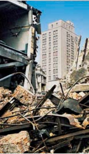
Jena wurde zur Großbaustelle.
